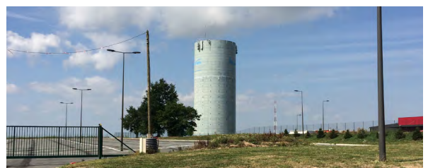
Réservoir d'eau potable à Montmarault [Source : Cittànova]
