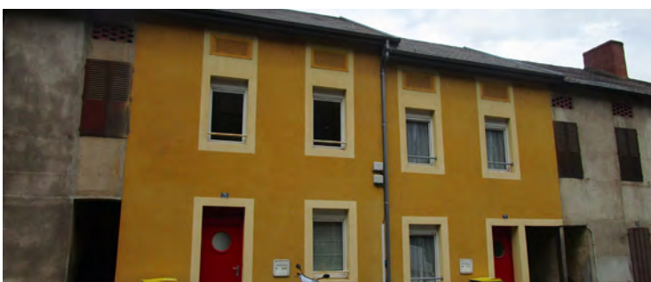
- Réhabilitations à Commentry -
