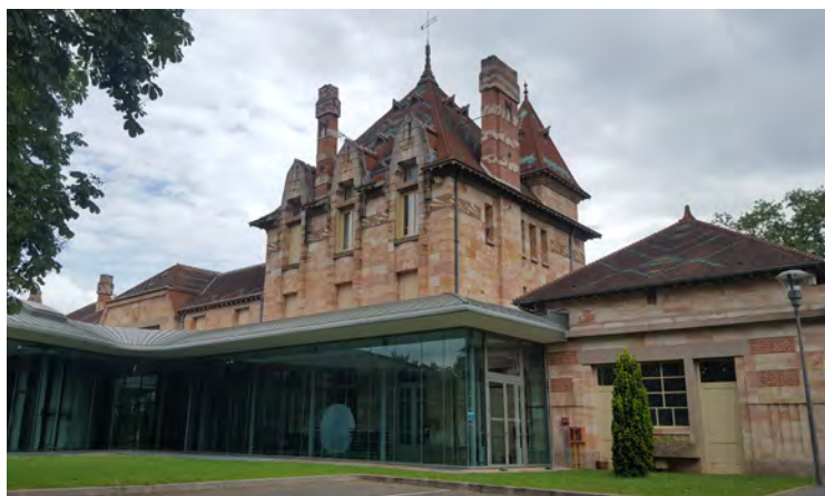
- Le pavillon du lac à Nérès-les-Bains -
