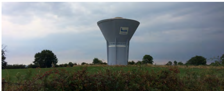
- Réservoir d'eau potable à Beaune-d'Allier -
