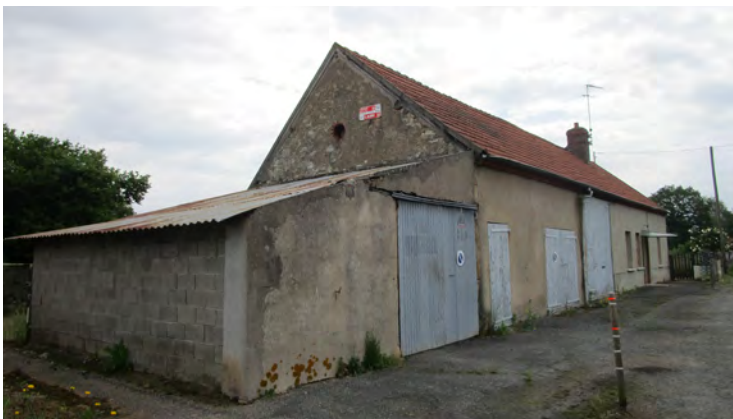
- Des projets de démolition/reconstruction à Chamblet pour accueillir la futur Maison d'Assistantes Maternelles (MAM) -
