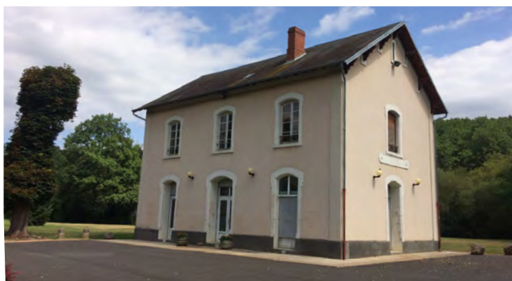
- Ancienne gare de Bézenet transformée en salle des fêtes -
