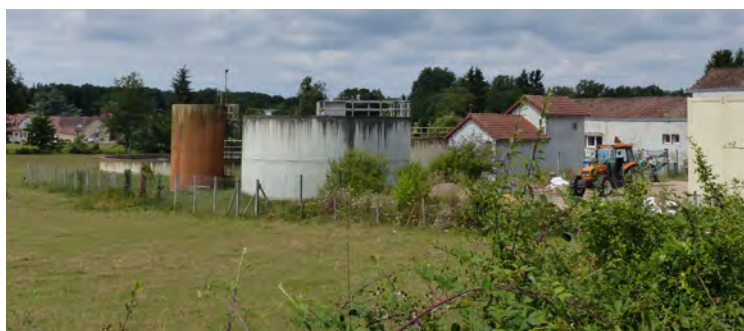
- Station d'épuration à Cosne-d'Allier -
