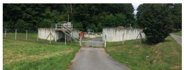
Station d'épuration à Bézenet, [Source : Cittànova]
