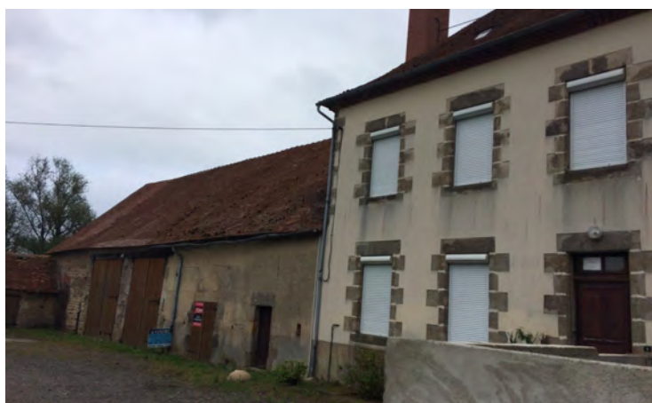
- Coffrets visibles à Voussac -
