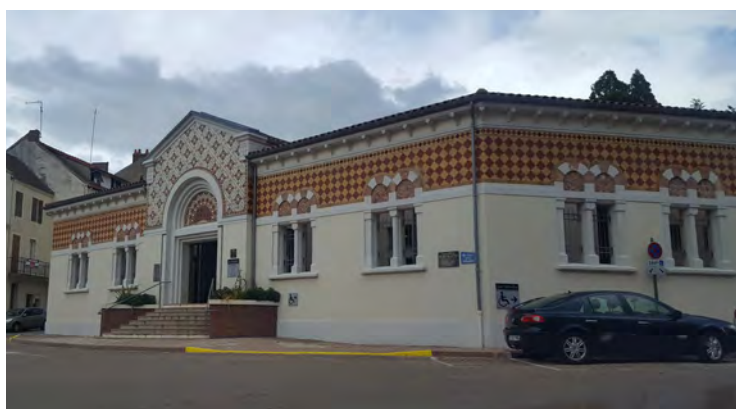
- Établissement thermal de 1ère classe place Jean Moulin -
