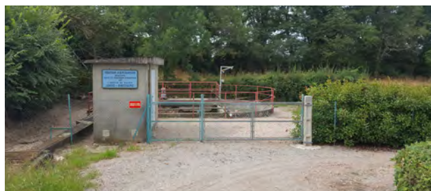
- Station d'épuration à Montvicq -
