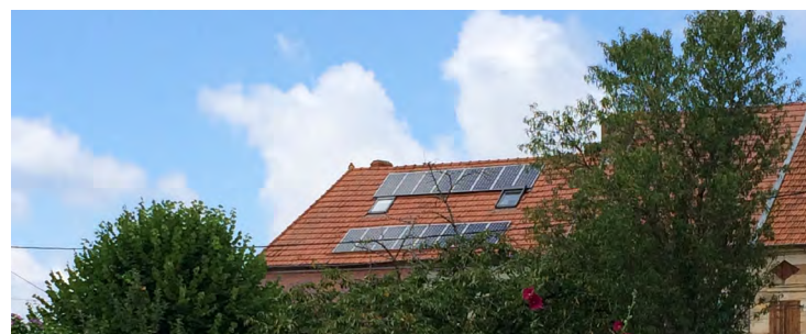
- Panneaux solaires sur un bâtiment ancien à Montvicq posant la question de la position -
