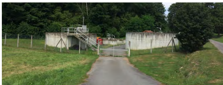
- Station d'épuration à Bézenet -
