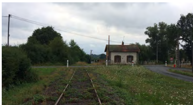
Ancienne ligne de chemin de fer à Villefranche d'Allier [Source : Cittànova]
