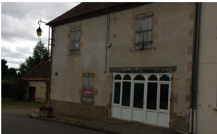
- Rupture dans les matériaux, Venas -
