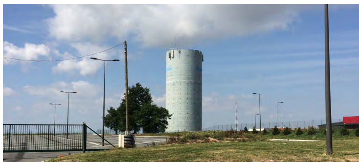
- Réservoir d'eau potable à Montmarault
